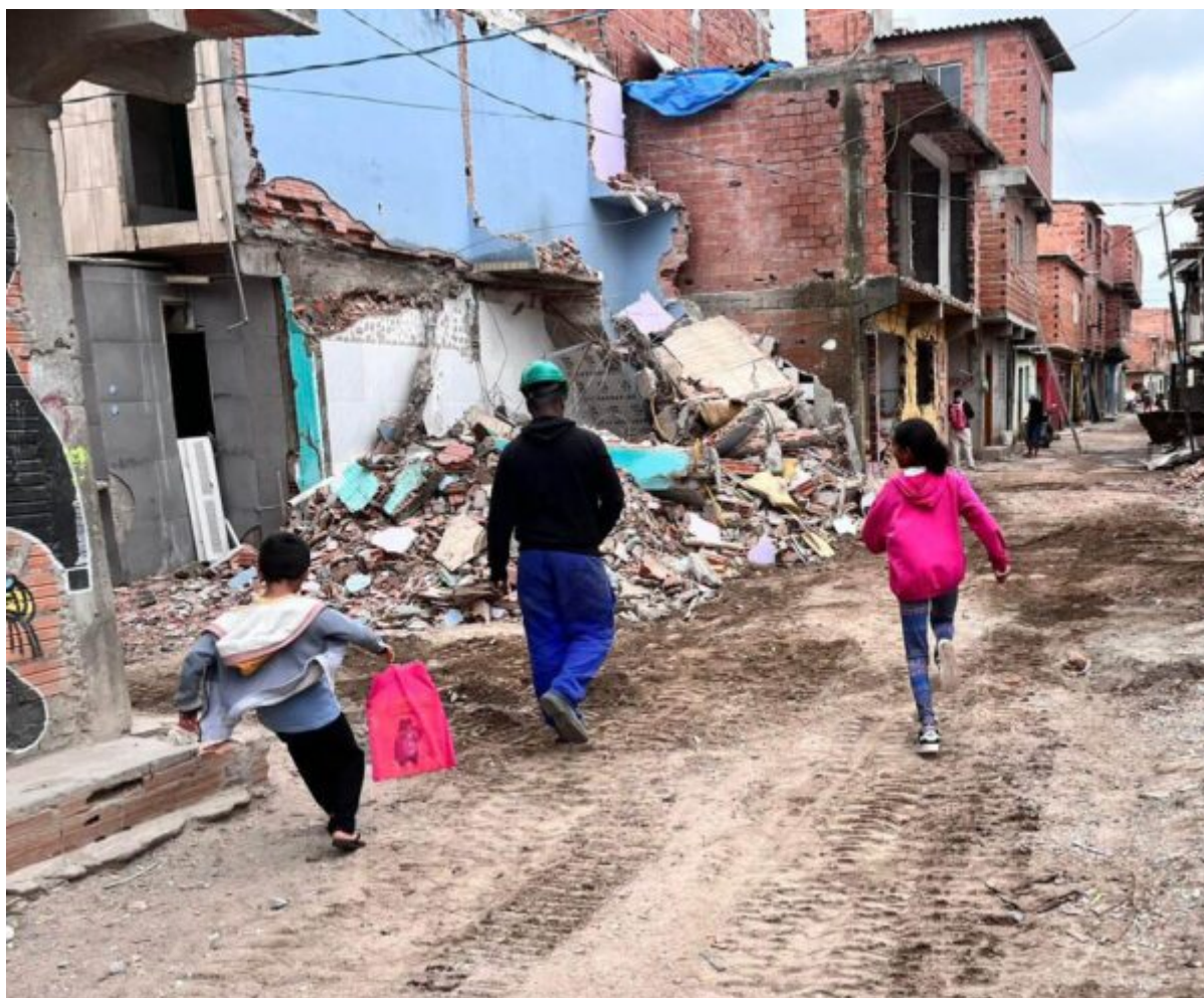
Crianças brincam próximas de entulhos deixados após demolições de casas pela CDHU na Favela do Moinho. Caio Castor, setembro de 2025
